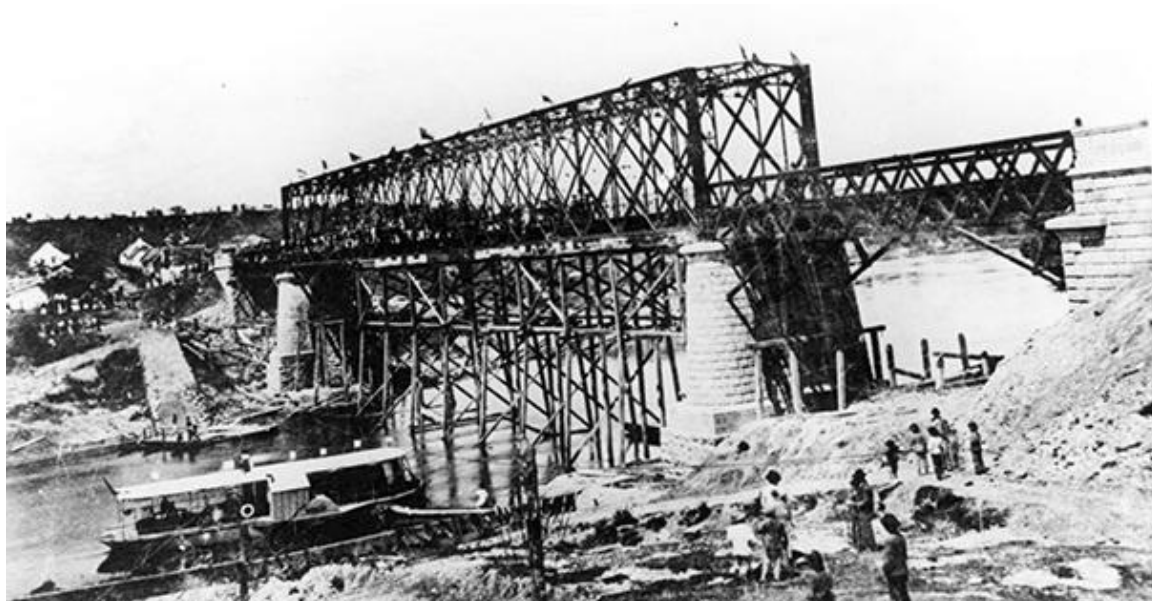
Imagem: Instalação da Ponte Dr Diniz Assis Henning.
